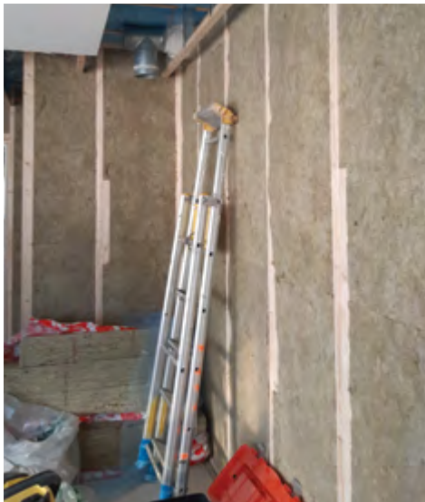
Lydisolering av alle rom er gjennomført
